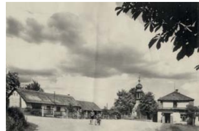
Hotel a restaurace U Novotných - Třebsín
